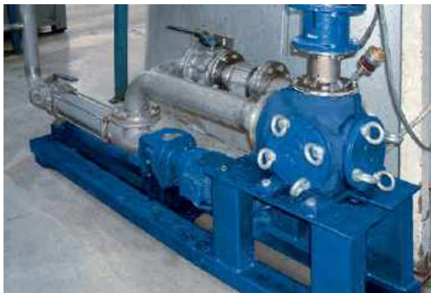
Pompe de la série BN 35-6L et macérateur 110l Produit transporté : divers déchets alimentaires Débit : 25 m 3 /h • Pression : 2 bars • Température : 40 °C
