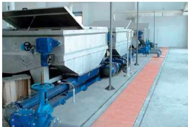
Pompes de la série BT 35-24 Produit transporté : boue épauvrissee Débit : 3-15 m³/h • Pression : 15 bars • Température : 20 °C
