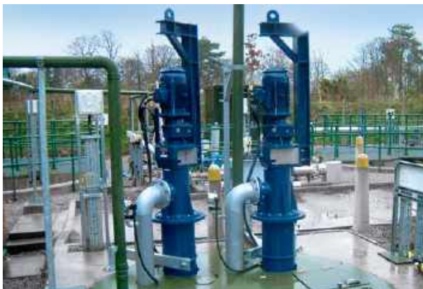
Pompes de la série BE 70-12 Produit transporté : boue primaire Débit : 21 m³/h • Pression : 3 bars • Température : 20 °C
