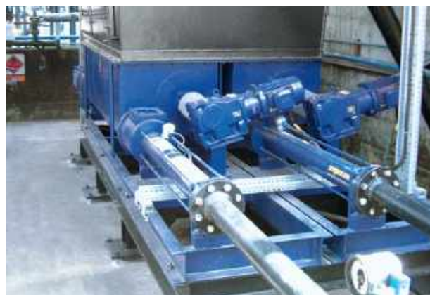
Pompes de la série BTEI 17-24, montées sur un cadre commun
