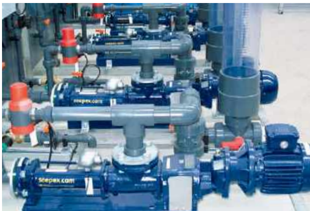
Pompes de la série BN 2-6L Produit transporté : solution polymère Débit : 500–2500 l/h • Pression : 2 bars • Température : 5–40 °C
