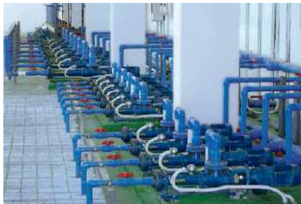
Pompes de la série BN 5-6L Produit transporté : solution polymère Débit : 4500 l/h • Pression : 4,5 bars • Température : 20 °C
