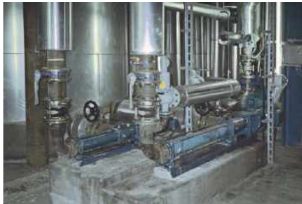
Pompe de la série BN 5-12 Produit transporté : Mélasse Débit : 1,7 – 5 m 3 /h • Pression : 7 bars • Température : 55 °C
