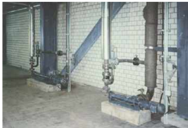
Pompes de la série BN 10-12 et BT 17-6L Produit transporté : Carbochaux Débit : 1,7 et 6 m 3 /h • Pression : 3 et 6 bars • Température : 20 °C
