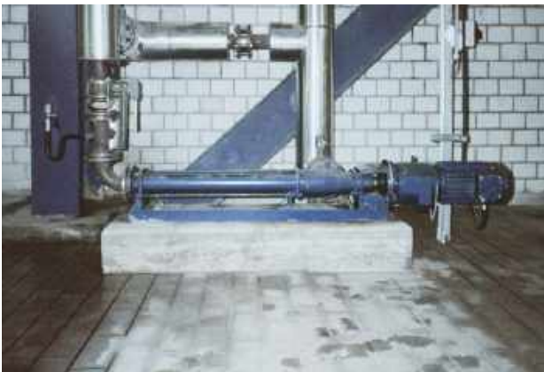
Pompe de la série BN 17-6L Produit transporté : Effluents A Débit : 13 m 3 /h • Pression : 3 bars • Température : 50 °C
