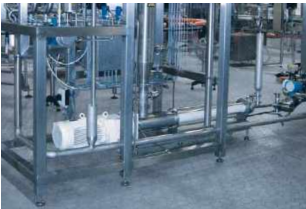
Pompe de la série BCSB 10-24 Produit transporté : purée de fruits Débit : 2 à 8 m 3 /h • Pression : 8 bars • Température : 7 à 12 °C
