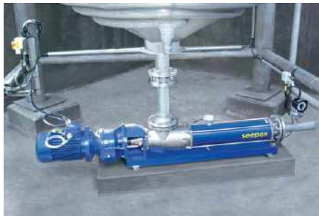
Pompe de la série BN 52-6L Produit transporté : sirop Débit : 10 à 50 m 3 /h • Pression : 2 bars • Température : 60 °C
